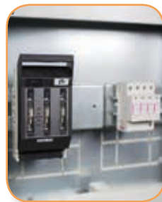
Saugiklių blokai LTL00 ir modulinė įranga
