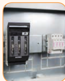
Saugiklių blokai LTL00 ir modulinė įranga
